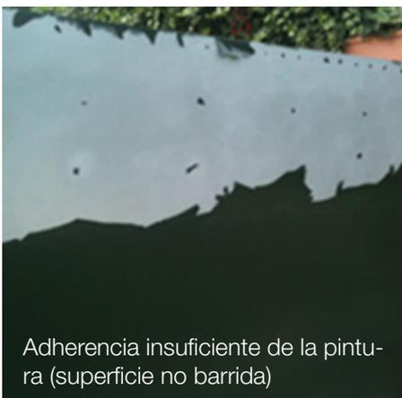
Adherencia insuficiente de la pintura (superficie no barrida)
